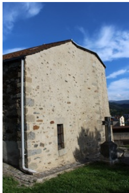
Façade ouest de l'église. Elle possède une fenêtre et une porte en bois massif. L'église est construite en partie en schiste, avec un chaînage d'angle en pierre de taille en granite.
