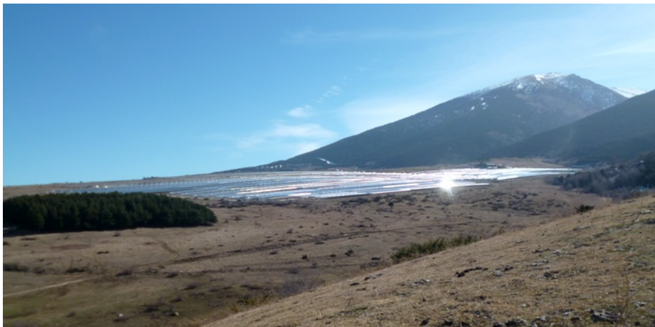
Centrale solaire eLLO
