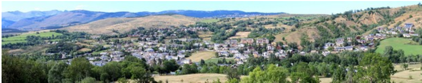
Vista general de Saillagouse - agosto de 2016
