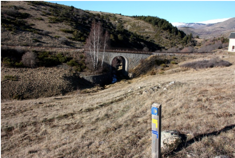
Passage du sentier sous un pont du train jaune
