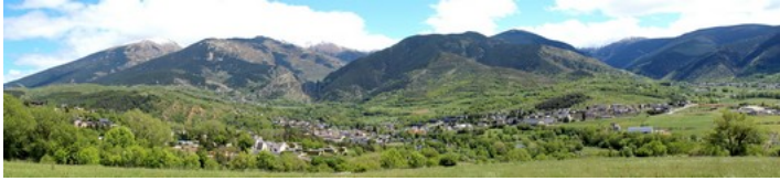
Vue générale de Saillagouse - mai 2015
